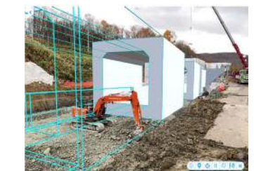
掘削作業時にARと比較
