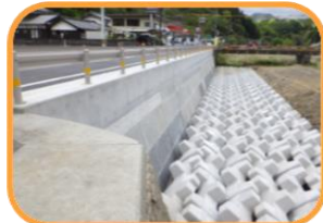
復旧後の状況(H31年4月26日)
