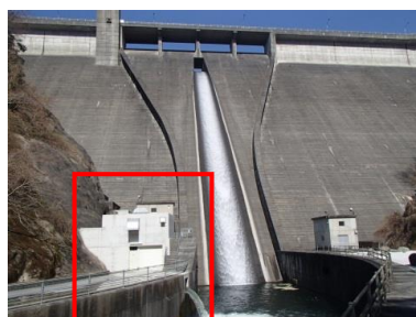
管理用発電施設（H24年度設置）
