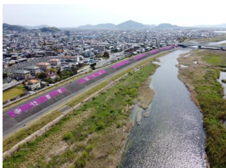
法面植栽（芝桜）を行った佐波川堤防
