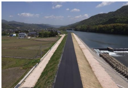
河川改修（奈美地区）
