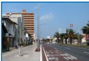
電線類の地中化
