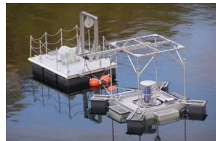
アオコ対策施設（H19年度設置）
