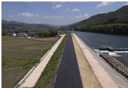
河川改修（奈美地区）
