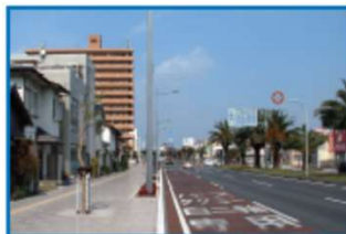
電線類の地中化
