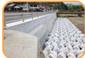
復旧後の状況(H31年4月26日)
