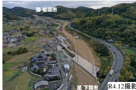
【写真②】石原地区の施工状況
