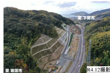
【写真①】椿峠地区の施工状況
