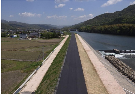
河川改修（奈美地区）
