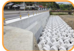
復旧後の状況(H31年4月26日)
