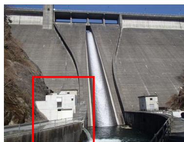
管理用発電施設(H24年度設置)
