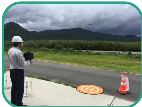
ドローンを利用した施設点検
