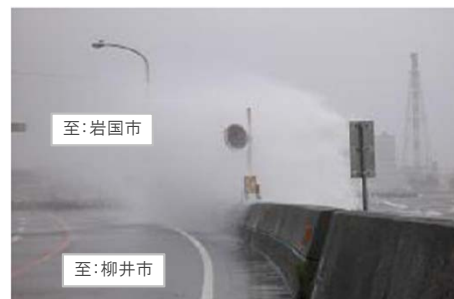
【写真①】越波の状況
