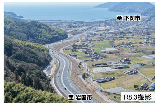
【写真①】4車線開通後（石原地区）
