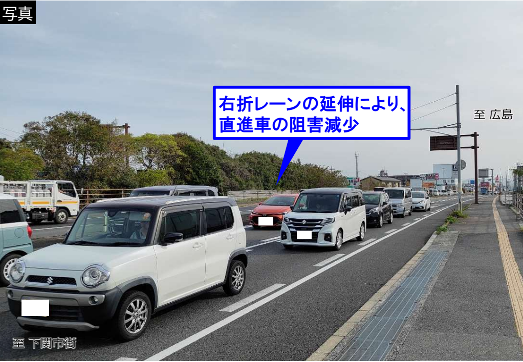
<対策後の現地状況>
