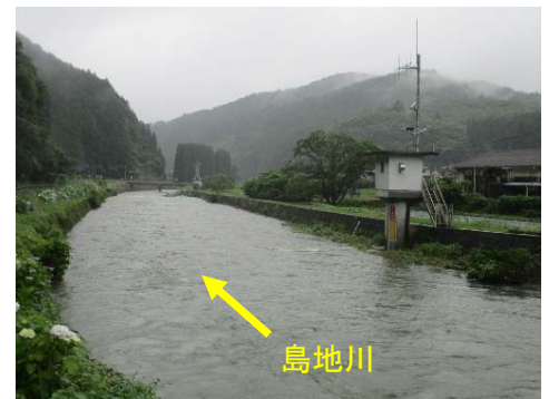
和田水位観測所の状況
