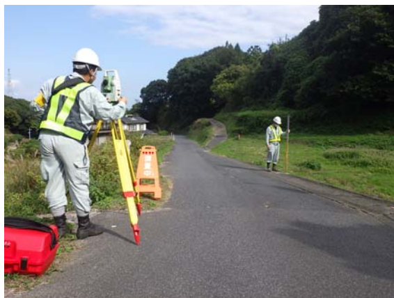
○測量作業の状況（地図作成）
