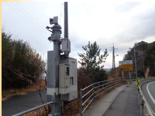
▲道路管理用カメラの更新 災害・事故発生時の情報を迅速に 収集する設備
