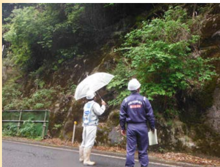
法面状況（長門市三隅）
