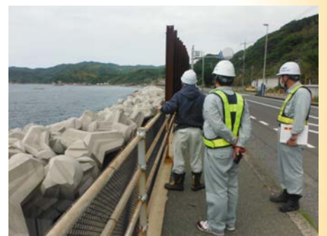
越波対策箇所点検（阿武町宇田）
