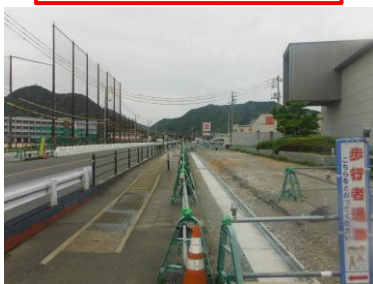
R8年度工事箇所
