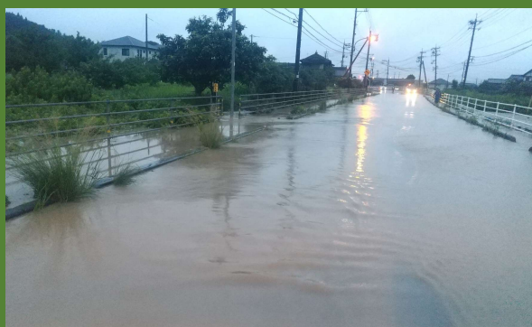
路面冠水による通行止め (国道188号平生町地内 R2.7.11)
