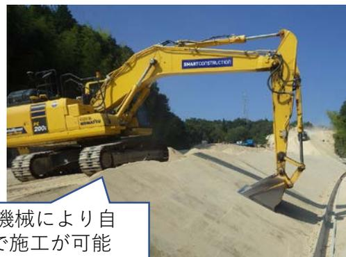
ICT建設機械により自動制御で施工が可能
