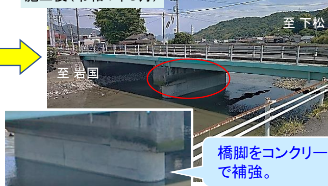
施工後(令和4年5月)
