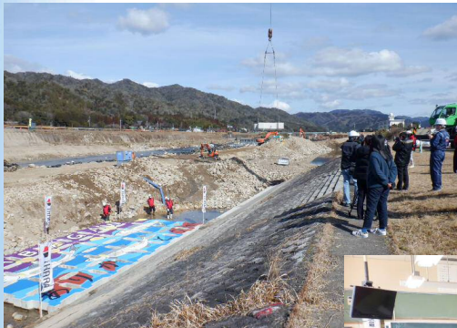
最後のブロックを現地に設置
