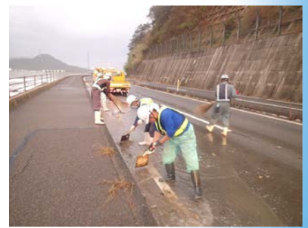
道路清掃状況
