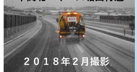
国道191号 下関北バイパス垢田付近
