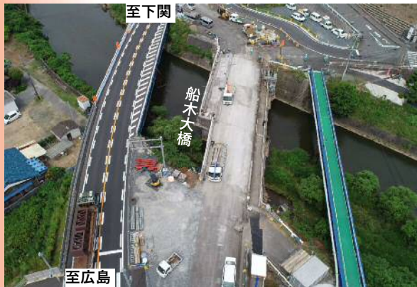
撤去前（令和3年6月30日撮影）
