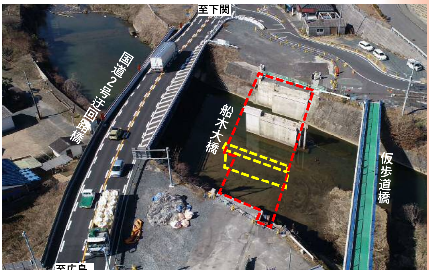
現在（令和4年2月28日撮影） 橋桁撤去 橋脚撤去
