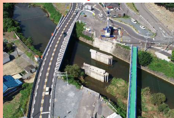
撤去中（令和3年8月31日撮影）
