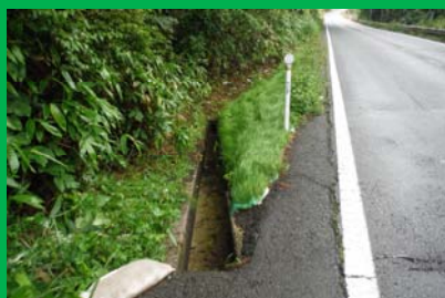
排水施設の点検
