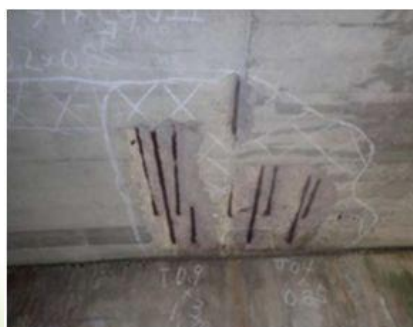
(断面補修・ひび割れ補修) 東松ヶ久保その1橋 樁床版橋 井手ヶ迫床版橋 千見折橋(上り・下り)
