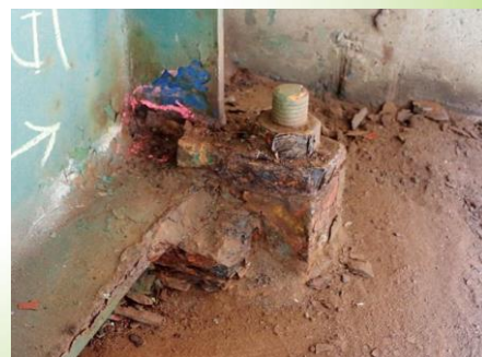
(支承の交換) 千見折橋(上り) 原跨線橋(上り)
