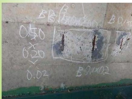
(床版下面補修) 千見折橋(上り)
