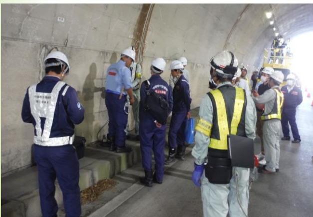
近接目視、ハンマー打診による点検
