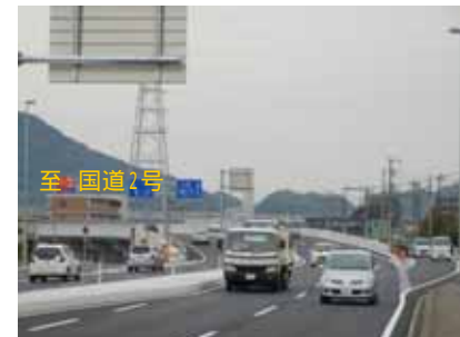
写真：拡幅後の状況 (粟島神社前交差点付近から国道2号方面をのぞむ)
