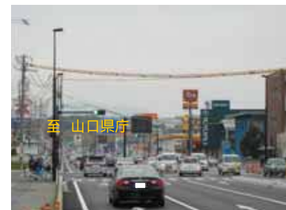
写真：拡幅後の状況 (矢足交差点付近から山口県庁方面をのぞむ)
