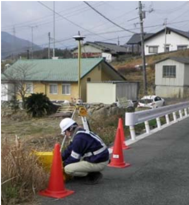
GPS観測機械による基準点測量(例)
