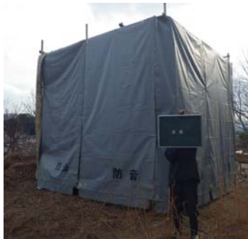
防音シート囲い(例)
