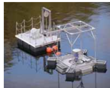
アオコ対策施設 (H20年2月完成)
