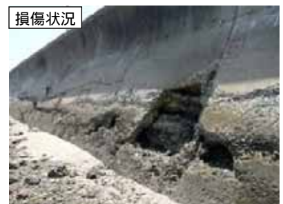
損傷状況 擁壁損傷状況(消波ブロック無区間)
