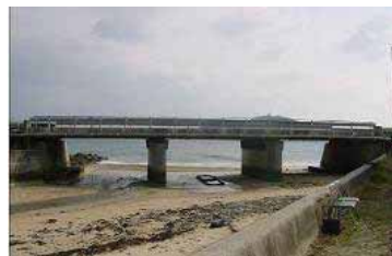
国道188号嘉永橋(山口県熊毛郡田布施町別府)
