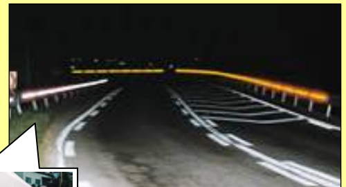
実施事例 (車両用防護柵への 反射材貼り付け)
