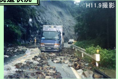
●現道(国道191号鎖峠)の災害状況
