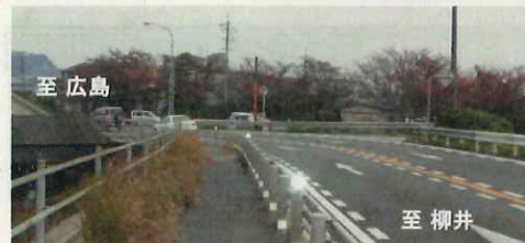
▲交差点柳井側の下り坂の急カーブの様子
