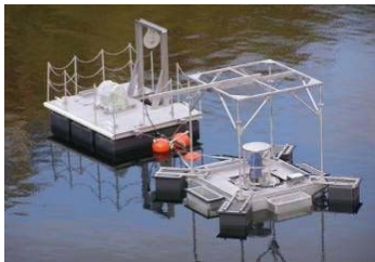
アオコ対策施設 (H20.2完成)
