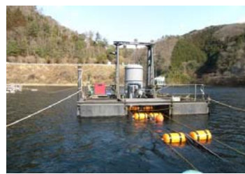
重金属対策施設 (H22.3完成)
