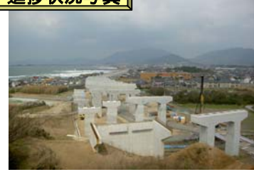
写真③工事施工状況(綾羅木地区)H24.3
