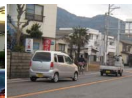
写真② 現道拡幅区間の状況
