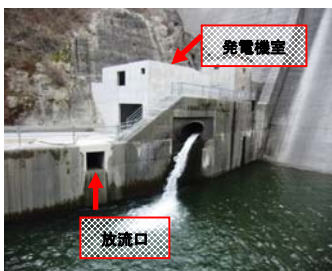
管理用発電施設の設置状況
