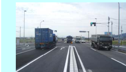
4車線化状況写真 写真③ H23.9撮影
