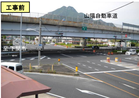
<県道54号側からの全景写真>
