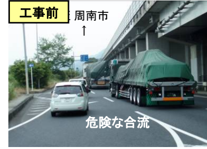
<下関市方面から周南市方面を望む [国道2号上り側]>
