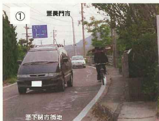
国道191号山口県下関市川棚地内
