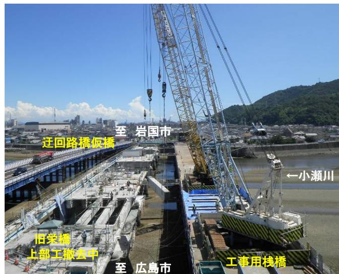
★ラオス研修生の現地見学の他に、旧栄橋の撤去工事状況がご覧頂けます。現在は、旧栄橋の上部工をクレーンで撤去中です。
