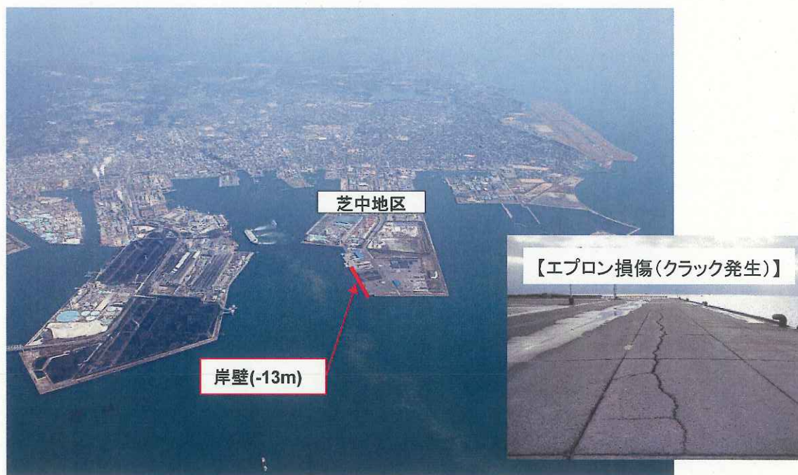
宇部港芝中地区岸壁(-13m)
