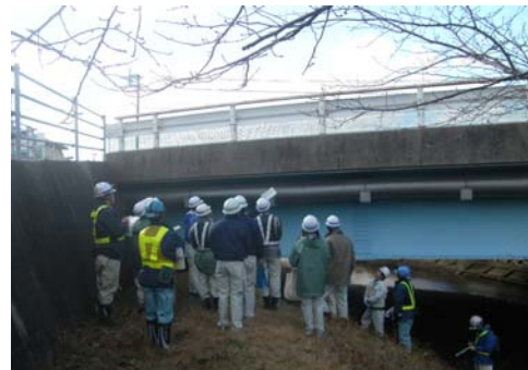
合同点検状況
