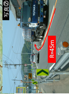
写真② ▲路形不良箇所の状況(永照寺付近[益田方面を見る])
