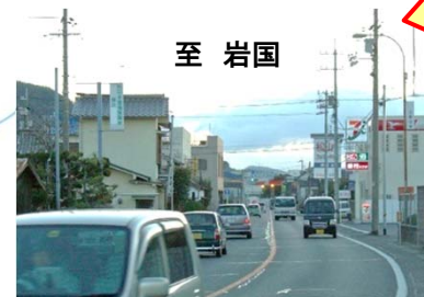
(H20年12月撮影) 整備前の現道拡幅区間の状況【写真①】
