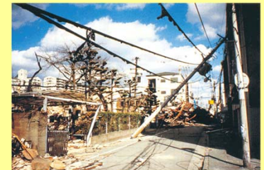
阪神大震災で倒壊した電柱
