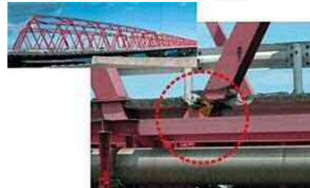
橋桁の破断
