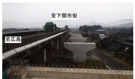
【写真①】松屋ランプ施工状況 (橋を造っています)
