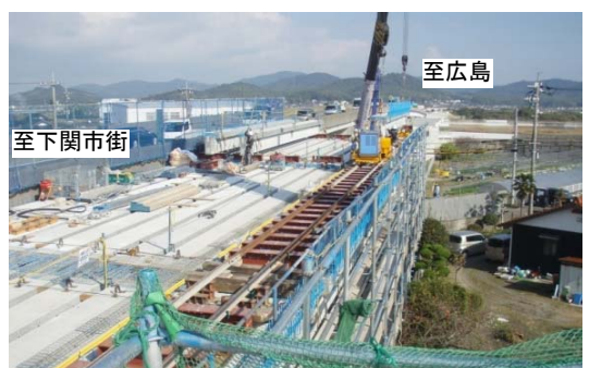
【写真②】木屋川大橋第2高架橋施工状況 (橋を架けています)
