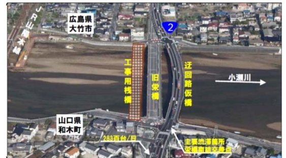
【写真①】施工状況(山口県側から広島県側を望む)
