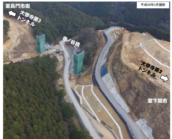
写真① 事業進捗状況 (長門市深川湯本(赤ノ谷)から長門市街方面を望む)
