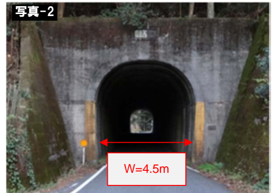
▲狭隘トンネル
