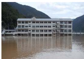
H26.8避難所2階の浸水 (徳島県)
