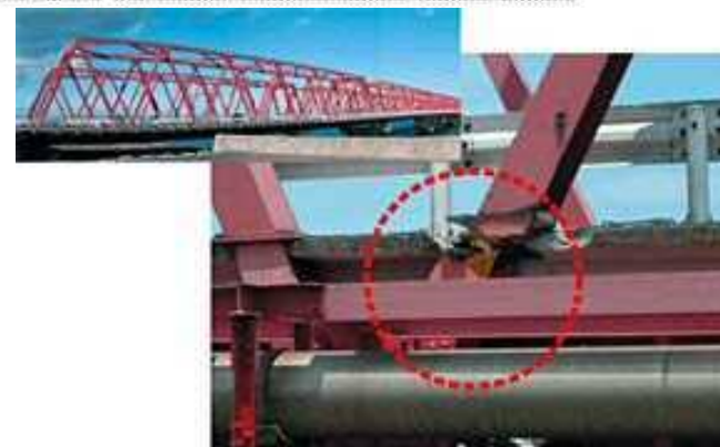
橋桁の破断
