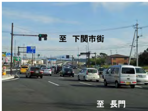
(H28年5月撮影) 富任交差点付近の状況【写真①】
