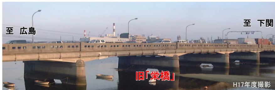
架け替え前の旧橋の外観
