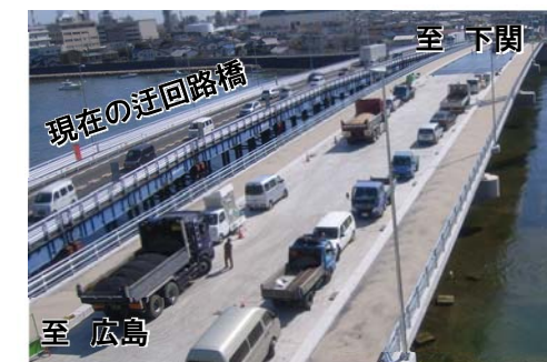
【写真①】新しい栄橋の状況
