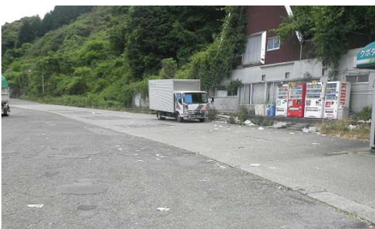
国道2号土生の駐車帯全景
