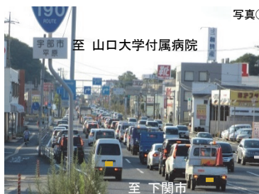
<国道190号 上り線 藤山交差点以西>
