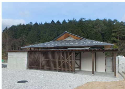
▲ 道の駅「願成就温泉」トイレ全景
