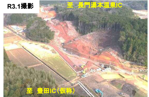
写真① 金道地区施工状況
