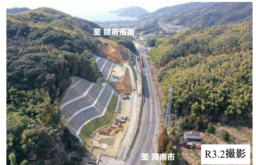
【写真①】現在の改良工事進捗状況 (周南市方面から防府市方面を望む)
