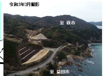
写真① 宇田地区施工状況
