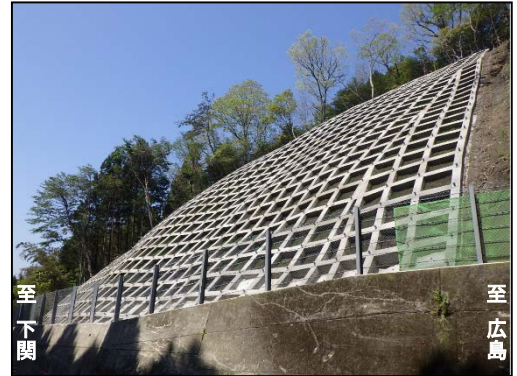
防災工事完了状況 (R3.4)
