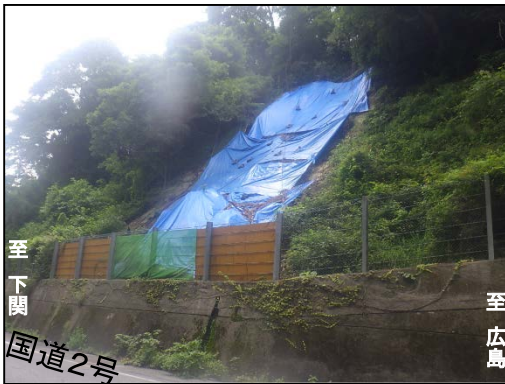
被災状況 (H30.7)
