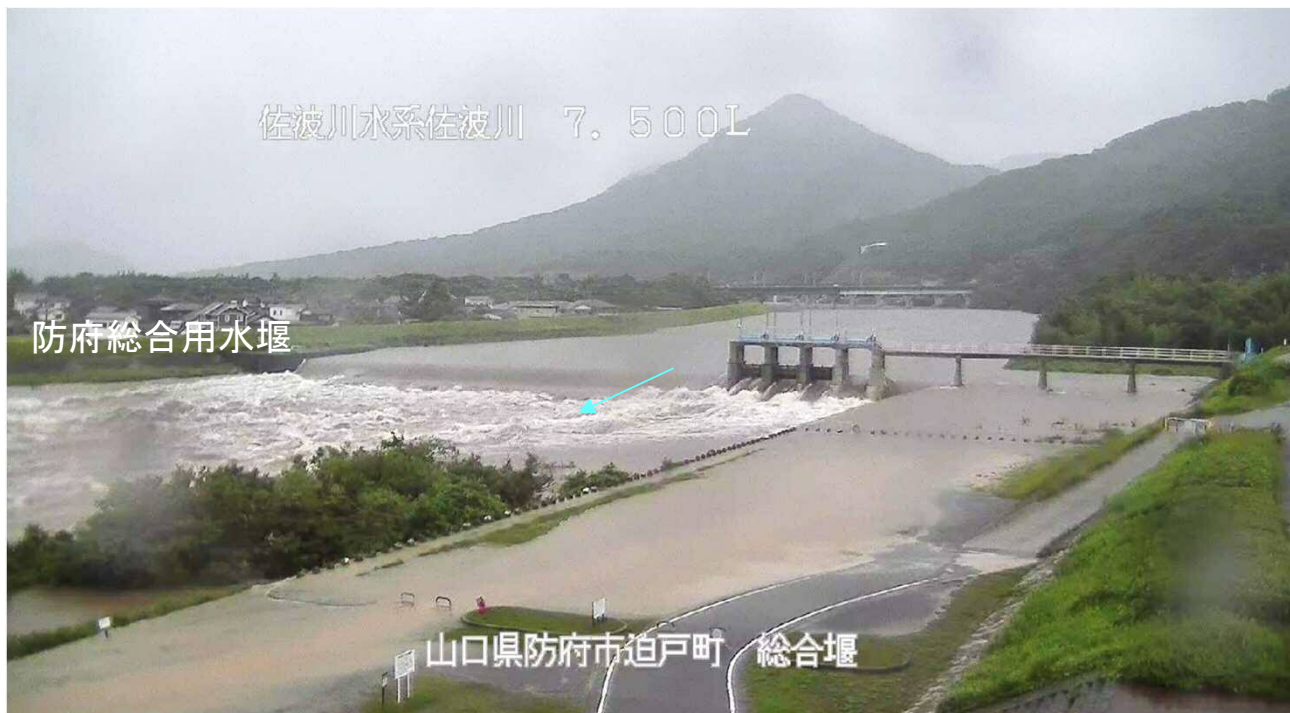
令和3年8月14日6時30頃の防府総合用水堰地点の状況(河川流量約950m 3 /s)
